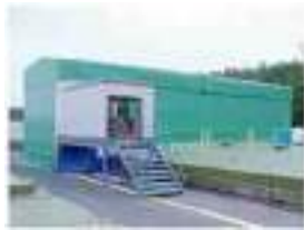
大型防護テント
