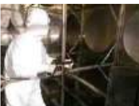
排水設備内の清掃
